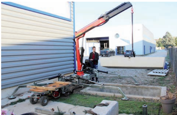
On aperçoit sur la photo du dessus la manipulation des anneaux en ciment, le chariot ayant été dégagé de la mini-pelle pour exécuter d'autres tâches. La mini-pelle, équipée d'une flèche Palfinger, est dotée de tous les accessoires (godets, crochets, ventouses, etc.).
